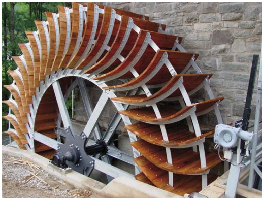
Wasserrad und Generator, Wulfsmühle
